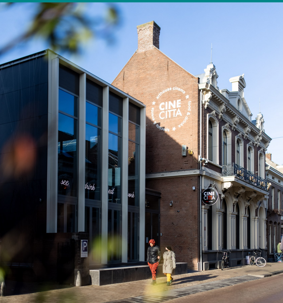
Cinecitta - Tilburg | Opening 22 oktober 2020. In de grond zijn twee nieuwe filmzalen gerealiseerd. Daarnaast is er een glazen Atrium gebouwd.
